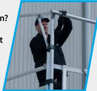
Während der Überprüfung des Fahrgerüsts wird eine zertifizierte Fachkraft eine gründliche Sichtprüfung durchführen. Dabei wird das Steigmaterial auf Beschädigungen und Defekte kontrolliert. Es wird geprüft, ob der Zustand des Materials noch dem Zustand zum Zeitpunkt der Lieferung durch den Hersteller entspricht. Die Lebensdauer des Materials wird verlängert, wenn das Steigmaterial rechtzeitig ausgetauscht und/oder repariert wird. Wird das Fahrgerüst zugelassen, kann es sicher eingesetzt werden.
